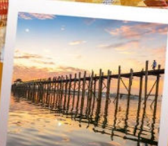
สะพานไม้จุงบิง
